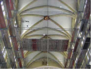
Sanierungsarbeiten im Hohen Chor, 2011
